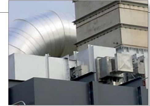
Un sistema secundario de recuperación de calor devuelve energía al proceso o a otros consumos energéticos de la planta
