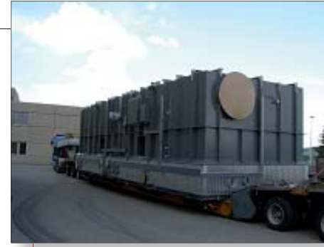
Installation d'un EPSILON 3 lits d'un débit de 60 000 Nm 3 /h : deux semaines de la livraison à la mise en service
